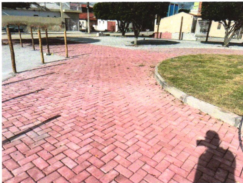
Foto 06 - Pavimentação em bloco de concreto vibroprensado, intertravado, colorido, 10x20cm, e=6cm, 46un/m 2 , NBR9781, Fck(min)=35MPa, sob coxim areia grossa compactada c/ placa vibratória, e(comp.)=6cm, rejuntado c/ areia fina.
