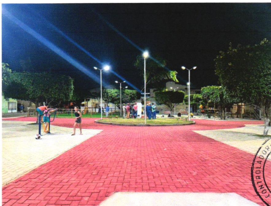
Foto 12 – Poste decorativo 2 pétalas, em aço galvanizado com difusor em vidro transparente temperado, com 3m/4m, inclusive lâmpada de led 50w
