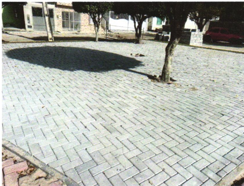
Foto 03 - Pavimentação em bloco de concreto vibroprensado, intertravado, cor natural, 10x20cm, e=6cm, 46un/m2, NBR9781, Fck(min)=35MPa, sob coxim areia grossa compactada c/ placa vibratória, e(comp.)=6cm, rejuntado c/ areia fina.
