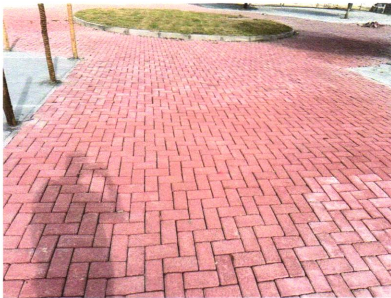
Foto 05 - Pavimentação em bloco de concreto vibroprensado, intertravado, colorido, 10x20cm, e=6cm, 46un/m 2 , NBR9781, Fck(min)=35MPa, sob coxim areia grossa compactada c/ placa vibratória, e(comp.)=6cm, rejuntado c/ areia fina.
